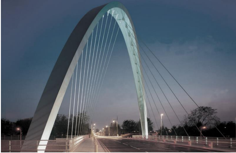
Brownlie Ernst and Marks – Hulme Arch Bridge, Manchester, Egyesült Királyság – 2012
